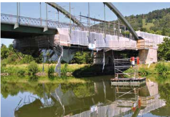
Das demolierte Baugerüst der Riedenburger Stadtbrücke
