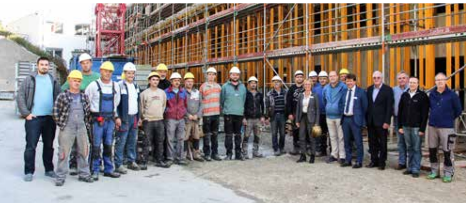
Der neue B-Bau soll 2021 bezogen werden. Die Arbeit der Bauleute wurde jetzt gewürdigt.
